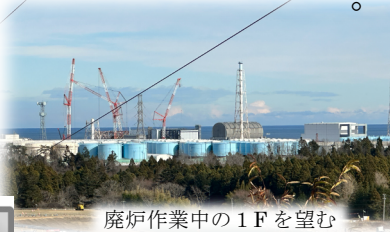
廃炉作業中の1Fを望む
